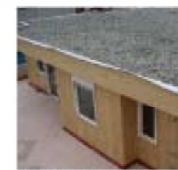
Haus mit Flachdachabdichtung
