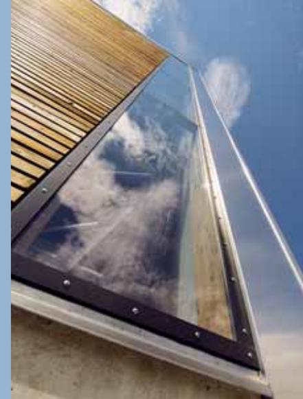
Dettaglio della lama di vetro intagliata nella parete est al fine di favorire l'ingresso alla luce naturale nel magazzino
