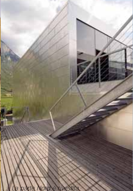
La parte Nord è rivestita con pannelli di alluminio
