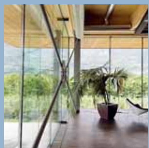
Le vetrate degli uffici sono a doppia camera con un coefficiente K di 0,7
