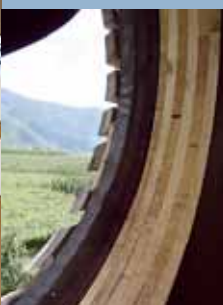
Il taglio ricavato sulla facciata est per incidere il nome dell'azienda consente di vedere la stratificazione della parete in legno
