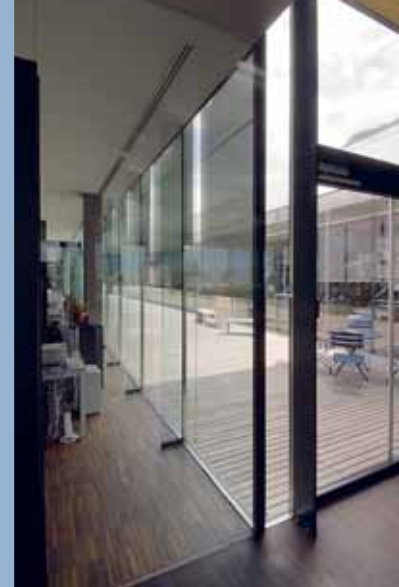
La creazione di terrazzo nel piano degli uffici ha lo scopo di offrire al personale un'area di sfogo e al contempo di permettere l'ingresso della luce naturale e favorire i guadagni termici solari. Durante l'estate, dei frangisole esterni proteggono le vetrate dal surriscaldamento
