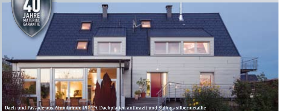
Dach und Fassade aus Aluminium: PREFA Dachplatten anthrazit und Sidings silbermetallic
