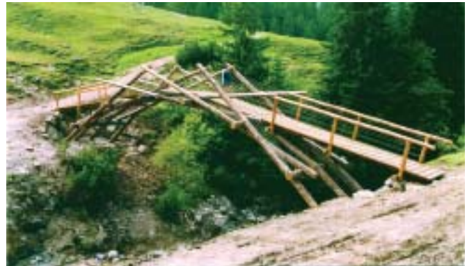
Bild 5: Die Brücke besteht aus einer bogenförmigen Hauptkonstruktion aus Rundhölzern und darauf „aufgelegten“ Rampen als Gehweg.
