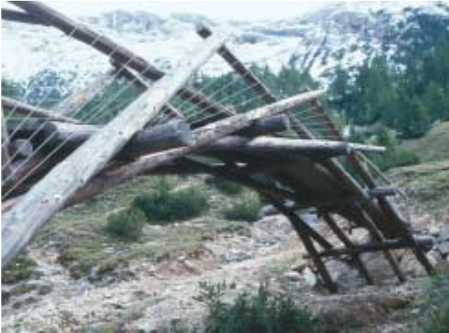
Bild 11: Gezähmte Natur mit „halb-wilder“ Brücke. Wie Spinnweben spannen dünne Stahlseile zwischen den Stämmen.
