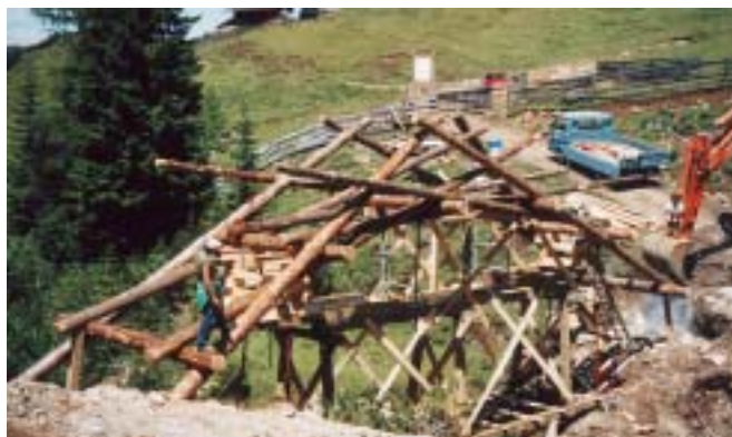
Bild 10: Auf einem Hilfsgerüst wurde die Grundkonstruktion über dem Flußbett „schwebend“ errichtet und nach dem Aufbau in die Endposition heruntergelassen.
