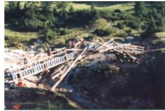
Bild 13: Belastungsprobe mit etwa 150 über die Brücke verteilten, 40 kg schweren, mit Sand gefüllten Kanistern.
